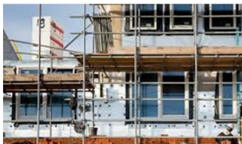
Figuur 10: een woning in aanbouw
