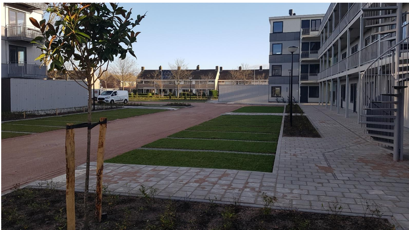
Water infiltrerende verharding op parkeerplaatsen in Schagen
