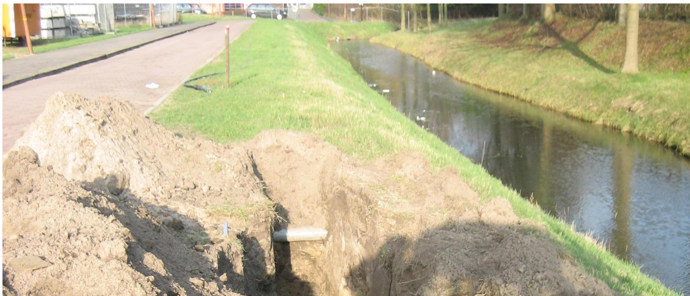
Rioolwerkzaamheden langs oppervlaktewatergang in Schagen
