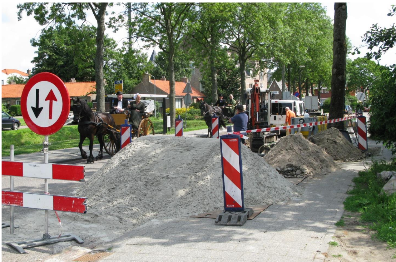
Werk aan riolering in Schagen
