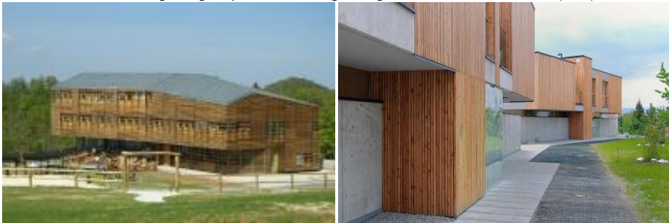
Installaties verborgen onder kapvorm, kap als 4 e gevel, interactieve plint (Krusec Architektura)
