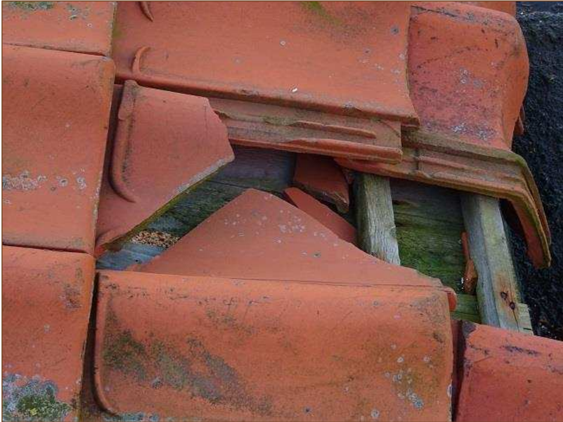
Foto 4. Geschikte nestlocatie voor gierwaluw en huismus onder de dakpannen van het hotelgebouw (foto: M. van der Lee).
