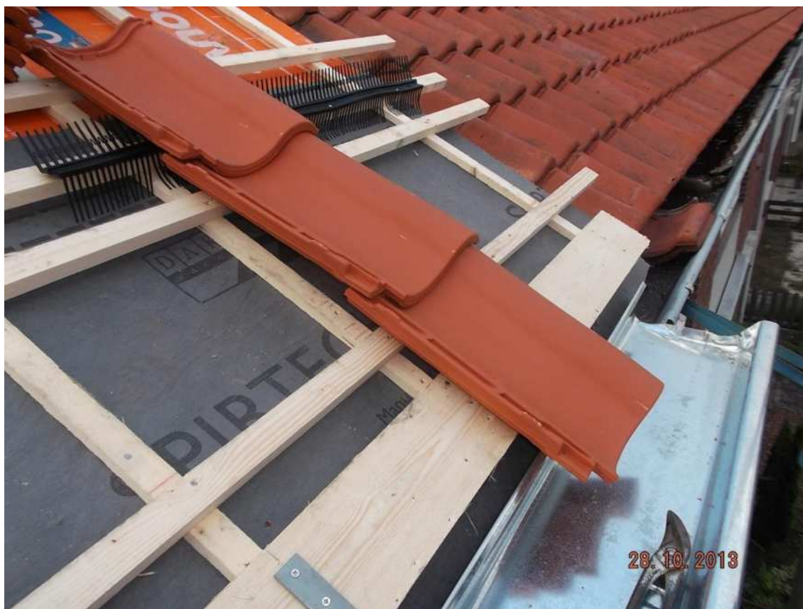
Afbeelding 9 Vogelschroot geplaatst tussen de 2 e en 3 e panlat.
