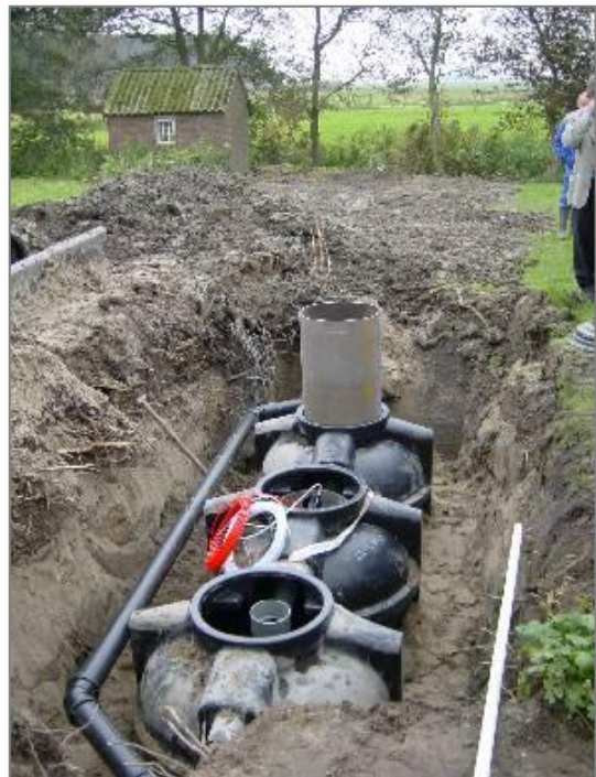
Figuur 6 Aanleg IBA in buitengebied
