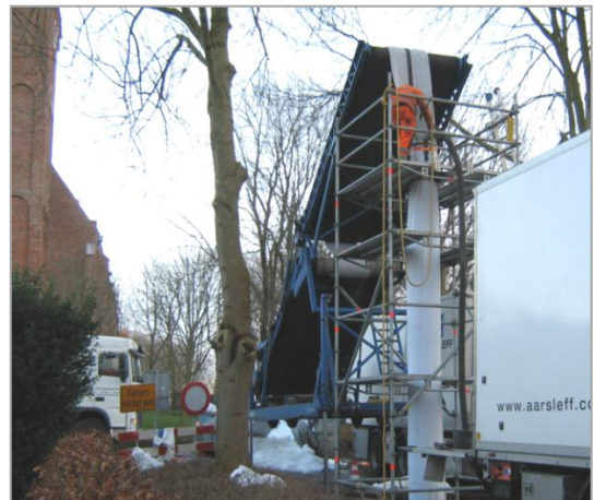
Figuur 1 Relinen rioolstreng Dorpsstraat, te Warmenhuizen (2012)
