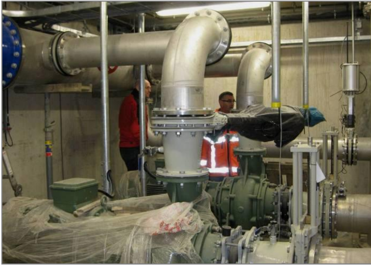
Figuur 11 Boostergemaal HHNK, aan het Noord 160 te Schagen, tijdens aanleg in 2010
