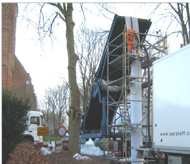
Figuur 2 Reline rioolstreng Dorpsstraat, te Warmenhuizen
