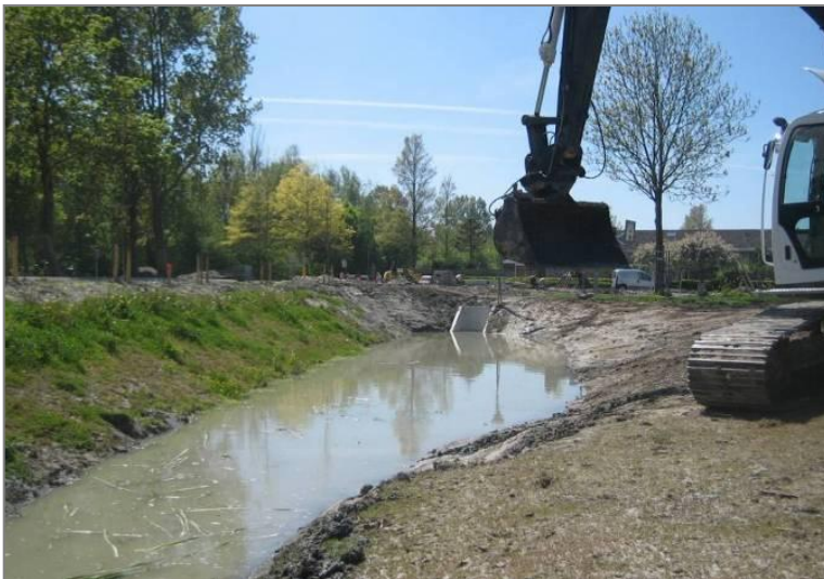
Figuur 15 Aanleg bezinkvijver Frans Halsstraat Schagen (2010)
