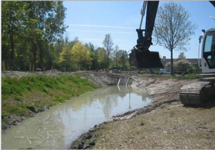
Figuur 2 Aanleg bezinkvijver Frans Halsstraat Schagen (2010)
