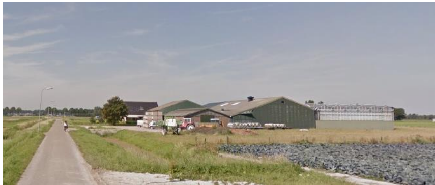
Zicht vanaf de Molenweg in noordelijke richting
