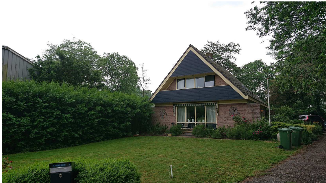
Figuur 5. Huidige bedrijfswoning op de projectlocatie
