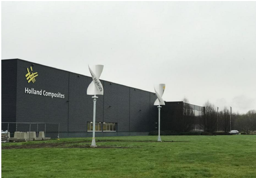
Figuur 3 Windturbines waarvan de as verticaal is georiënteerd op een paal (Windwokkel)
