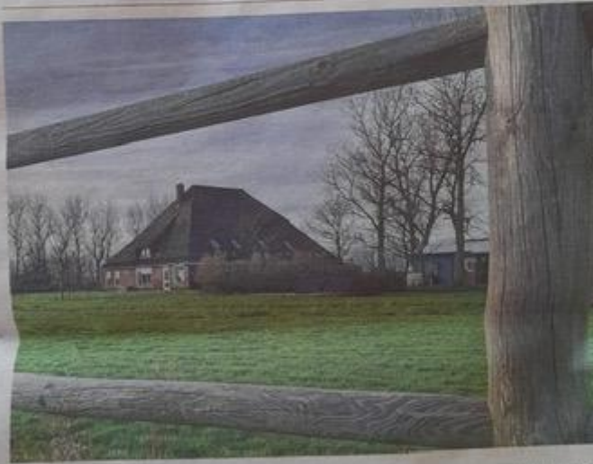
De strop aan Abbestede 8 mag worden gesplitst in twee zelfstandige woningen.
