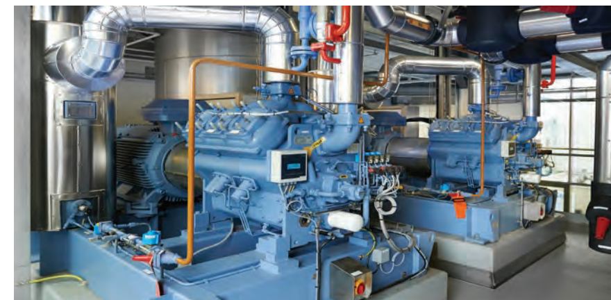
Grote industriële warmtepompen zorgen voor een lager energieverbruik.
