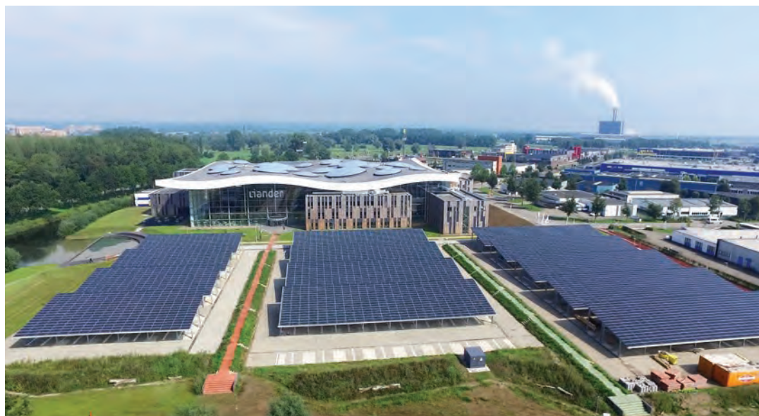
Energieleverend kantoor van Alliander in Duiven, ontworpen door Thomas Rau.
