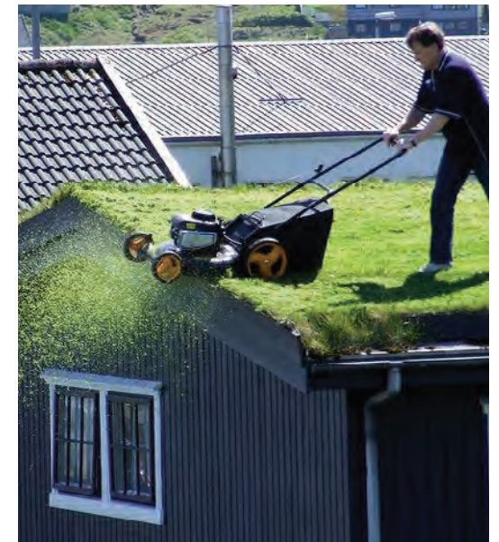
Een groen dak verkoelt en verbetert de luchtkwaliteit.
