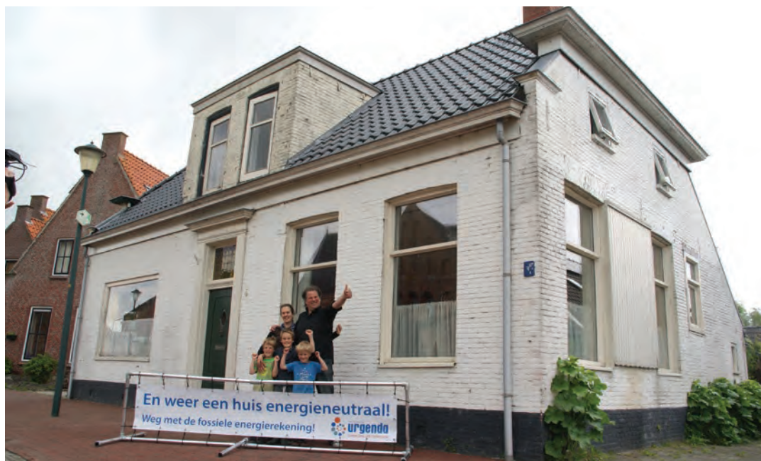
Energieneutraal gemaakt huis in Loppersum.
