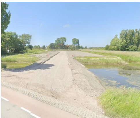
Uitrit met toegangsweg oostzijde
