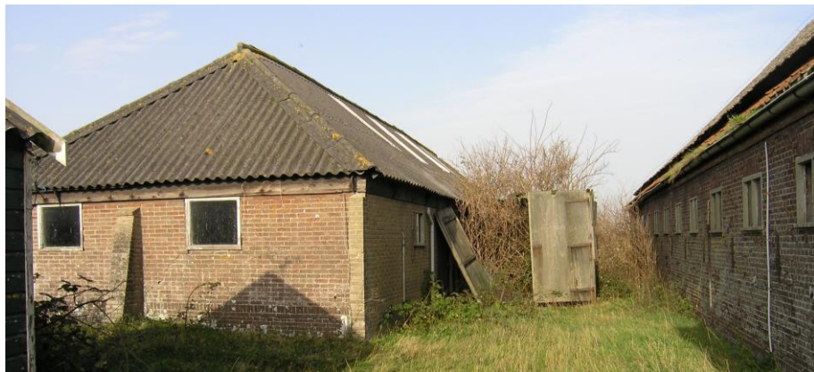
Schuur met golfplaten dak (16 oktober 2017)
