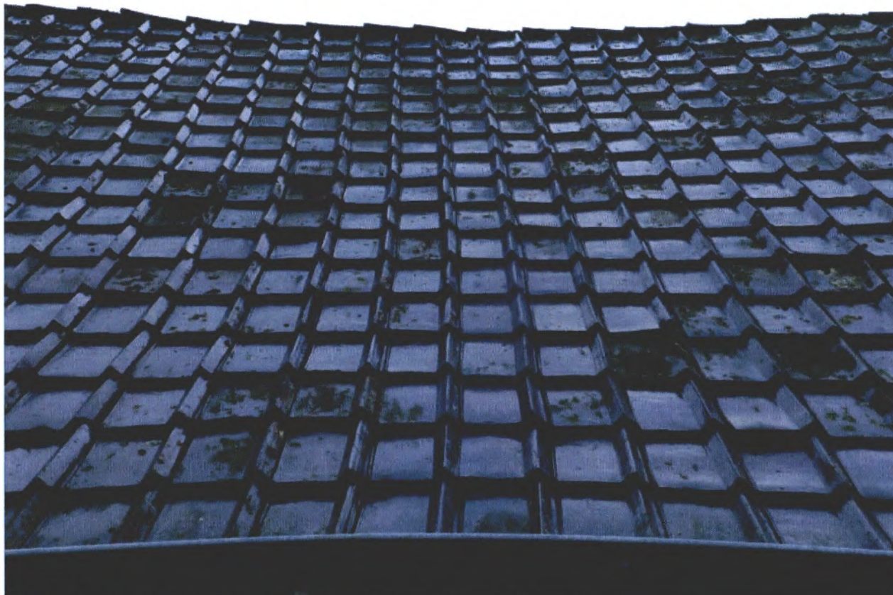
Afb.2: Detail van het pannendak. Pannen liggen zeer strak tegen elkaar aan.
