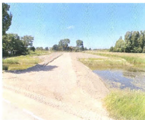
Uitrit met toegangsweg oostzijde
