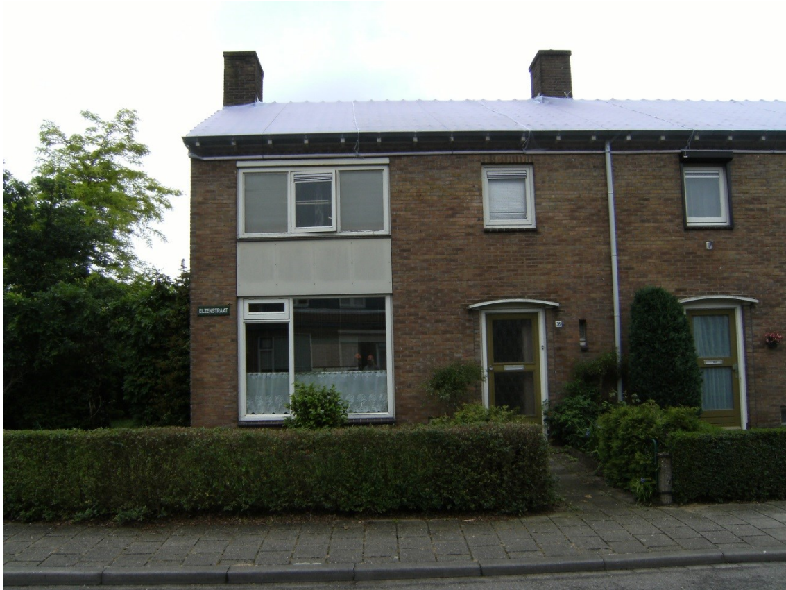
Afbeelding 10 met netten afgedicht dak bij een woonhuis.
