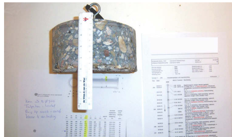
Onderzoek naar de afname van de wanddikte van een betonnen rioolbuis
