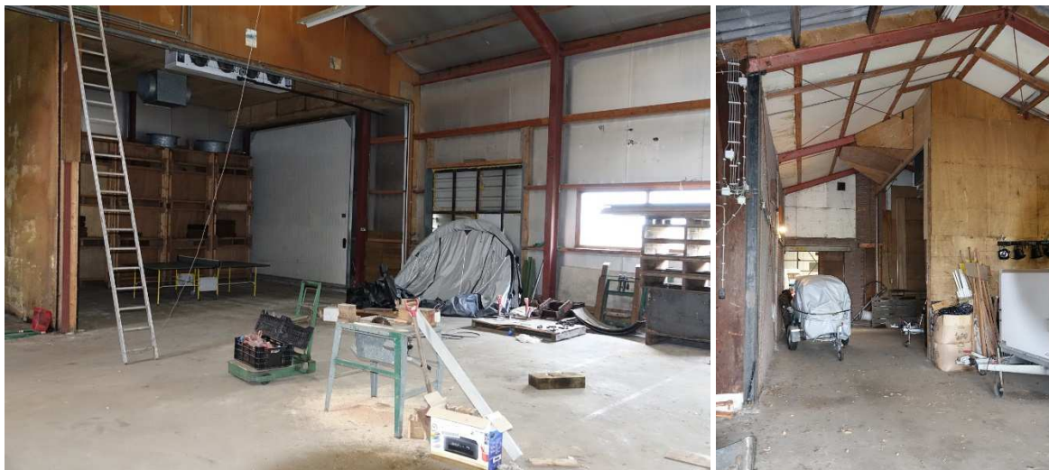
Figuur 2. Interne situatie van te verwijderen loodsen aan de Groteweg 25A te 't Zand.
