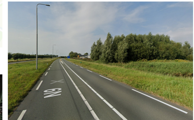
Figuur 16 | De rijksweg N9 ter hoogte van Schoorldam (bron: Google.maps.nl)
