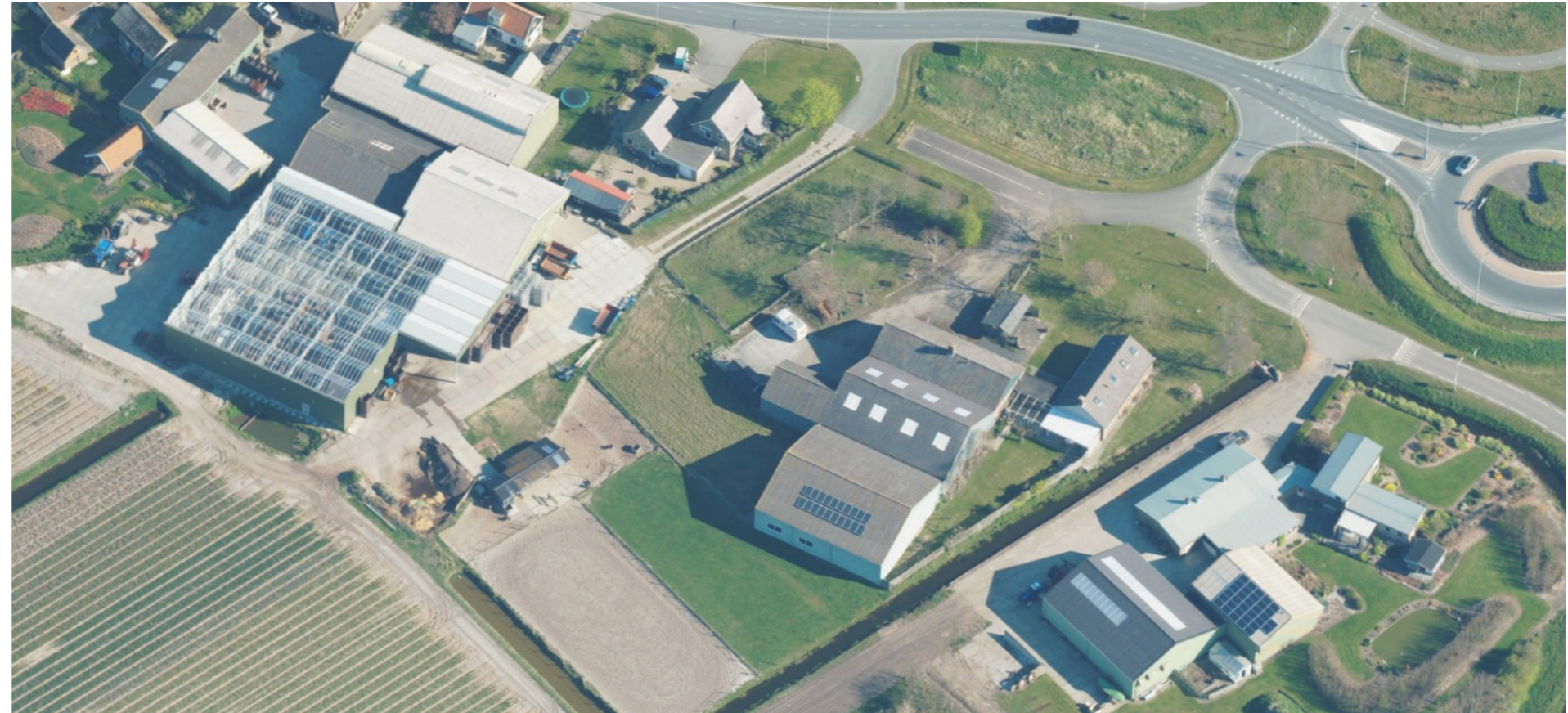
Figuur 29 | Dakvormen secundaire bebouwing Stolperweg (bron: Cyclomedia.nl)
