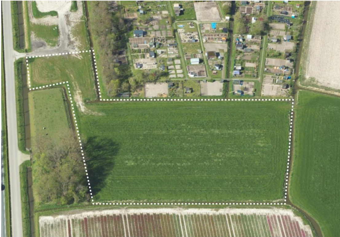
Figuur 2-1 Bovenaanzicht huidige situatie Bron: Streetsmart Cyclomedia
