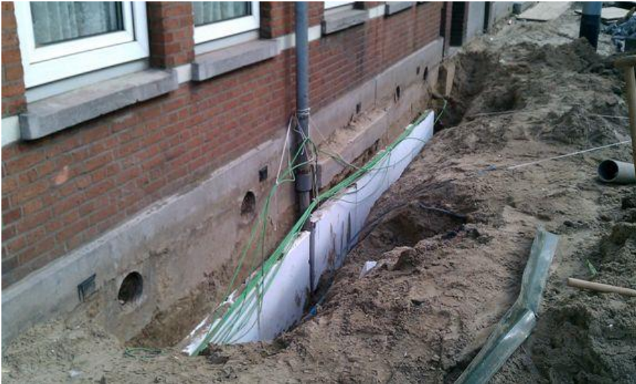
Figuur 7: Voorbeeld aanbrengen trillingsscherm
