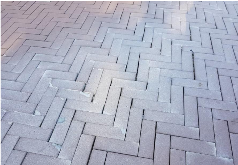
Figuur 5: Enkele foto's van het wegdek van de Voorburggracht ten tijde van de inspectie
