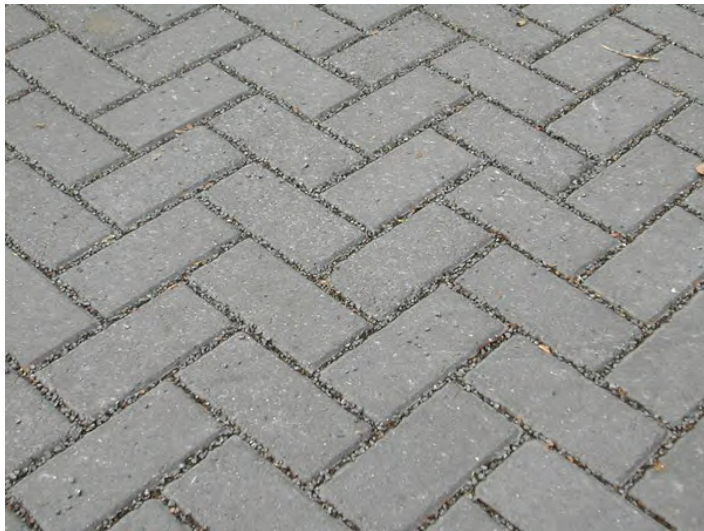
Bestrating rondom station Waterdoorlaatbare betonklinkers grijs
