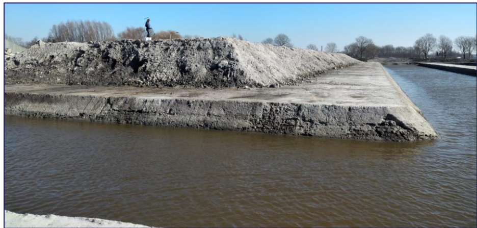
Figuur 10 | Gegraven bezinkbassin binnen de inrichting (Bron: Prommenz Milieu B.V.)
