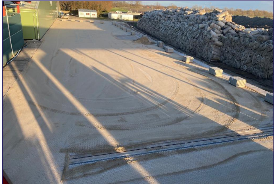
Figuur 14 | In aanleg zijnde vloestofkerende vloer, goot is niet meer aanwezig (Bron: Next Generation B.V.)
