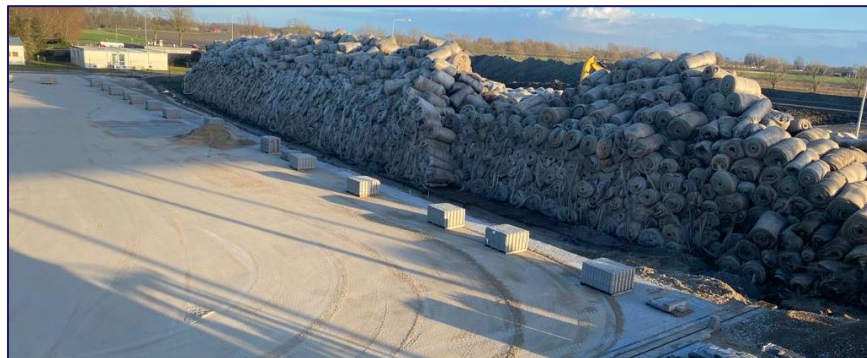
Figuur 3 | Huidige opslag tulpenbollennetten binnen de inrichting, deze komen te liggen op de vloeistofdichte vloer (Bron: Next Generation B.V.)
