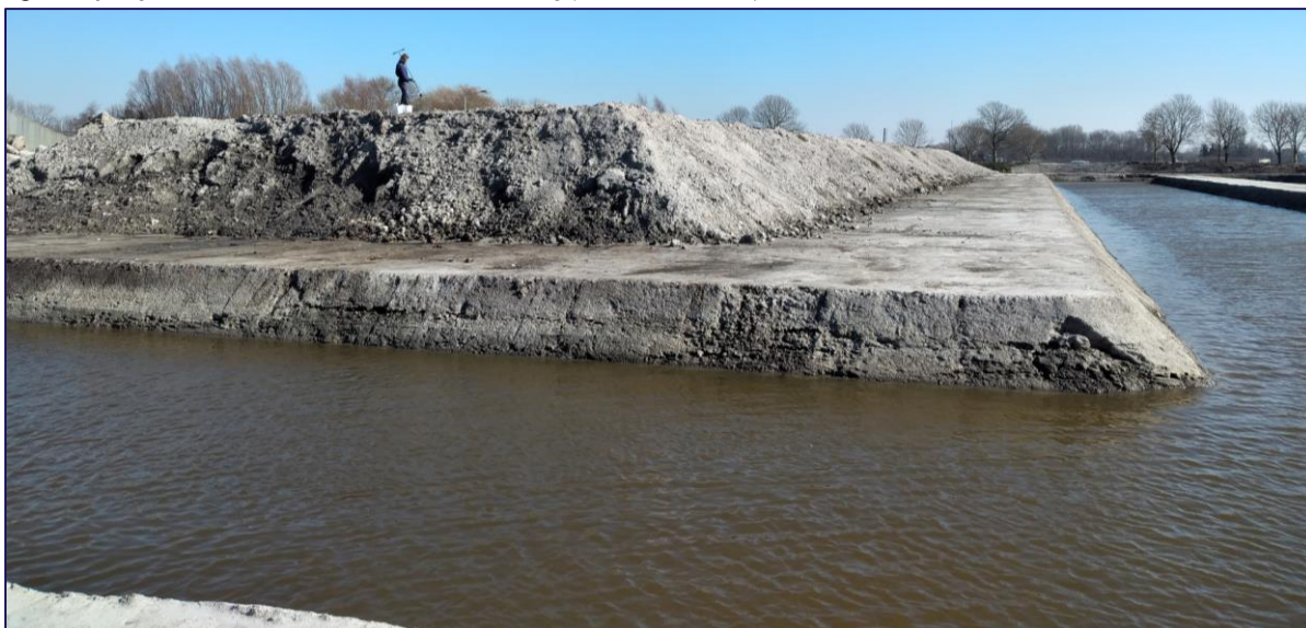
Figuur 7 | Gegraven bezinkbassin binnen de inrichting (Bron: Prommenz)
