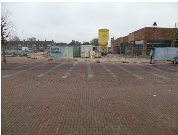
Uitbreiden waar geen parkeervakken zijn (bij de sierbanden)
