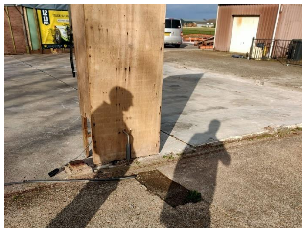
Locatie voormalige dieseltank
