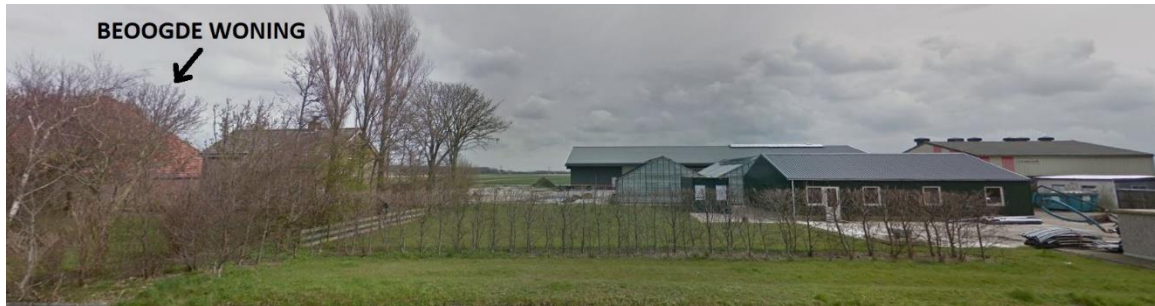
Afbeelding 2.3 Aangezicht bedrijf vanaf de straat (Langevliet) en ligging beoogde woonfunctie
