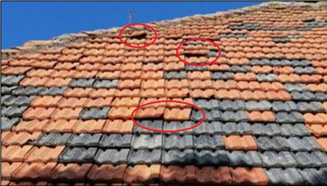
Figuur 7: Hellend dak van de oude boerderij met loszittende pannen.
