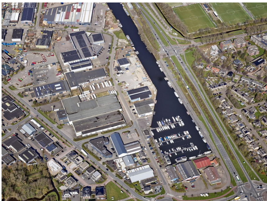
Foto 7: Bedrijventerrein Lagedijk van bovenaf gezien
