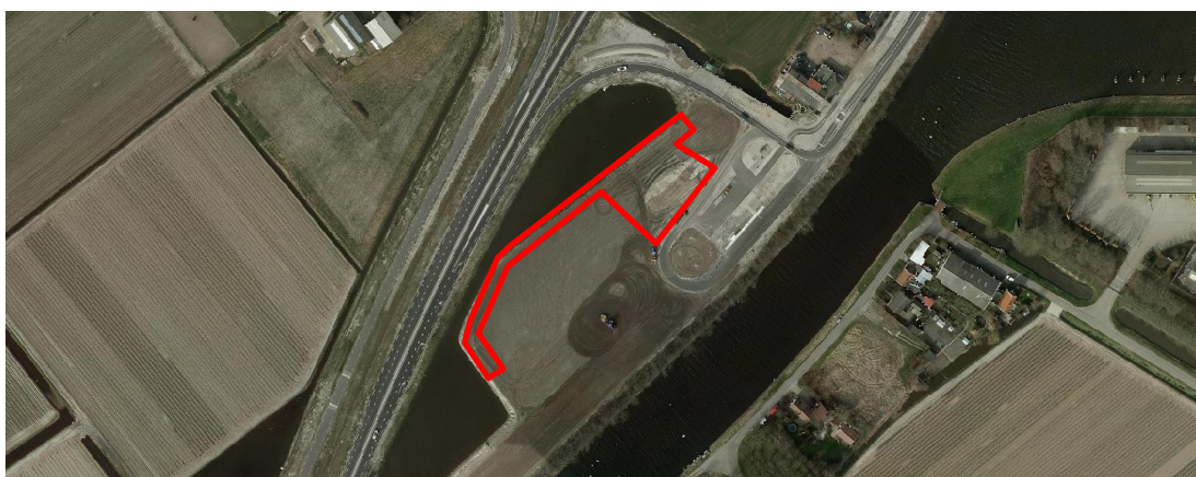
Figuur 5: Luchtfoto omstreeks 2012 (onderzoekslocatie binnen rode kader)
